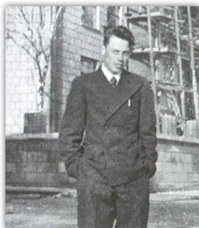
Рис. 1. Алексеев у строящегося корпуса Горьковского индустриального института
